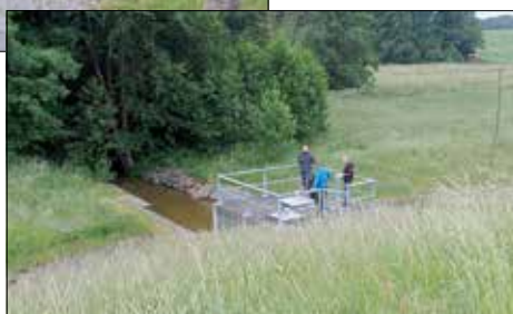
Kontrolle des Komplexbauwerkes für den Grundablass.
