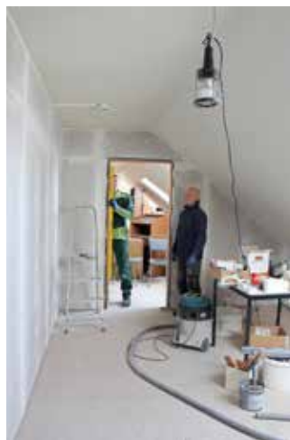
Gemeindearbeiter Enrico Franke und Klaus Eckert beim Einbau einer Tür.
