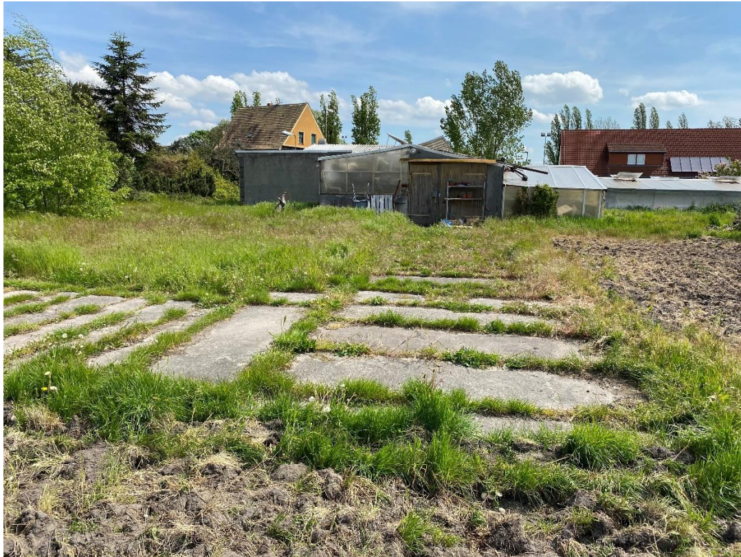
Abb. 7: Altbefestigung im Bereich des geplanten Wirtschaftsgebäudes
