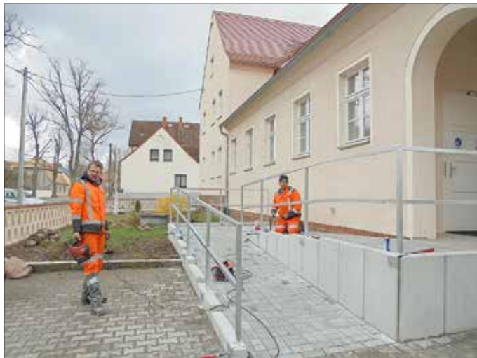
Die letzten Arbeiten waren das Anbringen der Eisengeländer.
